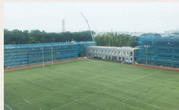
建設中の中学校校舎
